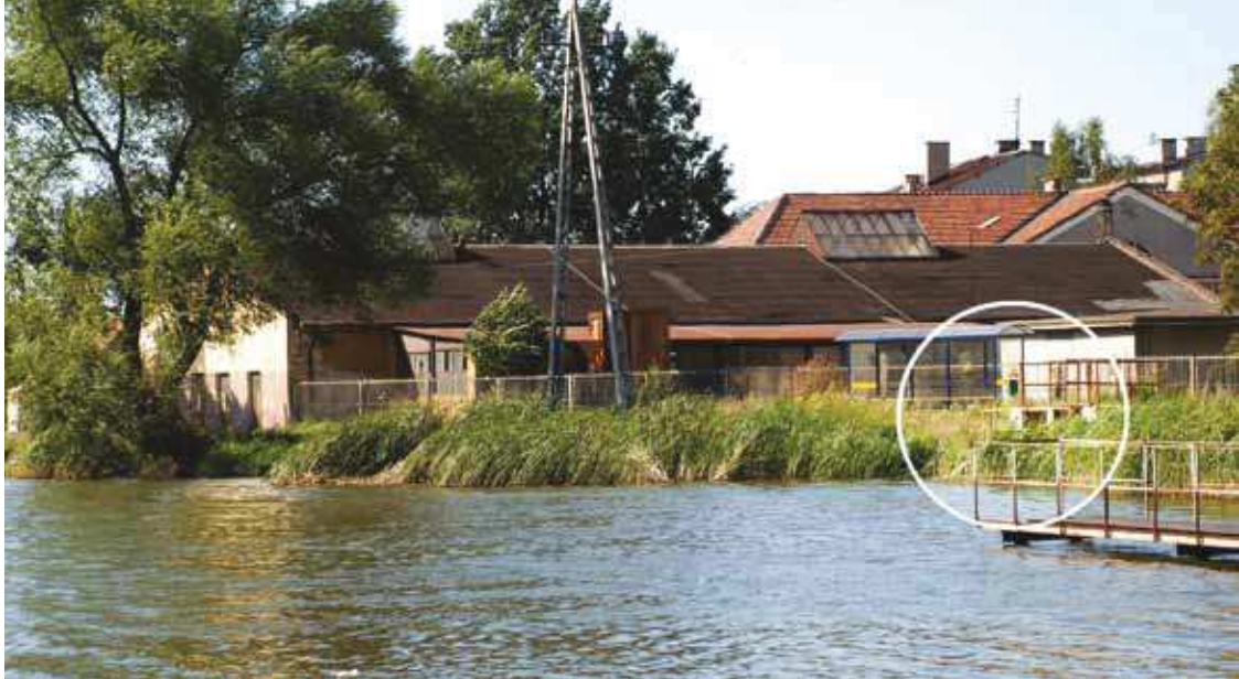
Ujście stawu do kanału biegnącego pod fabryką, fot. 2013
